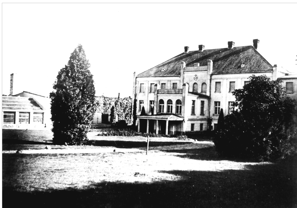
Ryc. 13. Dwór w Biesowicach, pierwsza połowa XX wieku, fot. dokumentacyjna w MNS, Archiwum Fotograficzne
